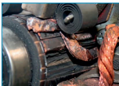
Povrch komutátoru je sklovitý. Ohnuté lamely komutátoru.
